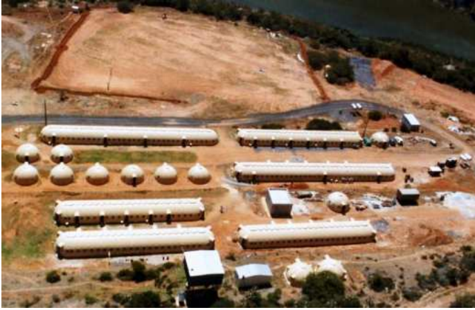
SLAGBOOM OPLEIDINGSENTRUM IN AANBOU
